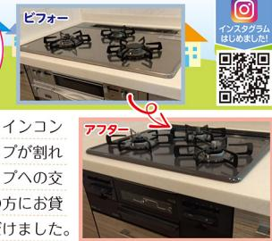
賃貸マンションにガラストップのビルトインコンロを設置していたのですが、ガラストップが割れてしまうので、割れにくいホーロートップへの交換工事です。これで安心して、入居者の方にお貸しすることができます!と喜んでいただけました。
